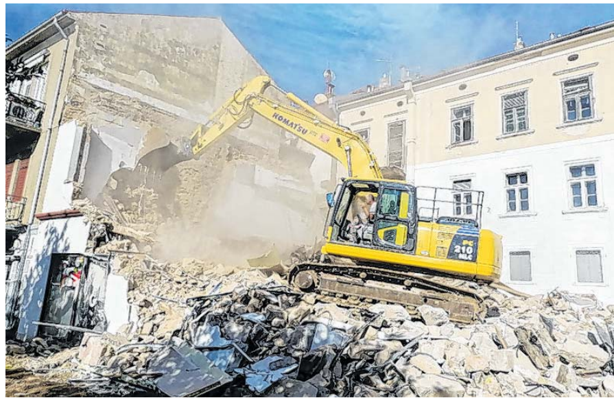
Na mjestu zgrade "nestale" u jedan dan gradi se boutique hotel
