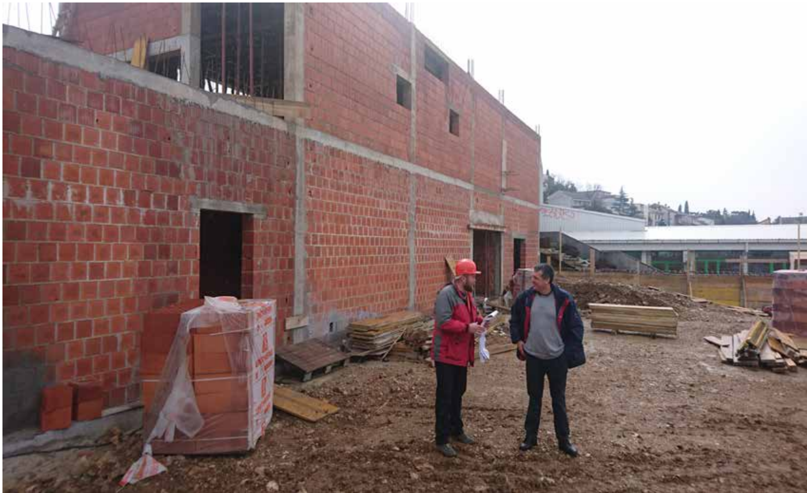
Gradonačelnik Grada Crikvenice Damir Rukavina obilazio je radove na izgradnji dvorane Osnovne škole Zvonka Cara u Crikvenici
