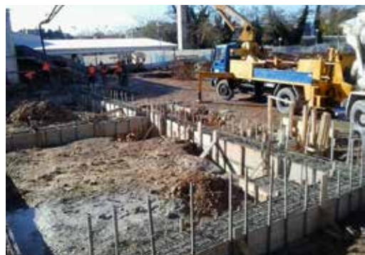
Radovi na izgradnji školske sportske dvorane OŠ Zvonka Cara u punom su jeku
