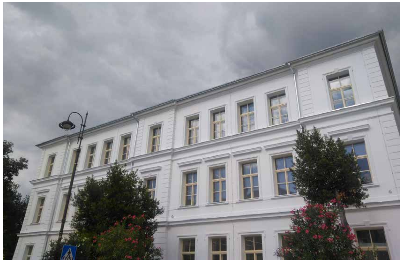
Obnovljena zgrada Stare škole već poprira novi, moderan sjaj, a uskoro se očekuje i useljenje prvih korisnika
