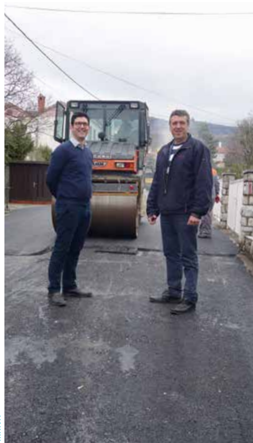
Gradonačelnik i njegov zamjenik u obilasku radova u Jadranovu
