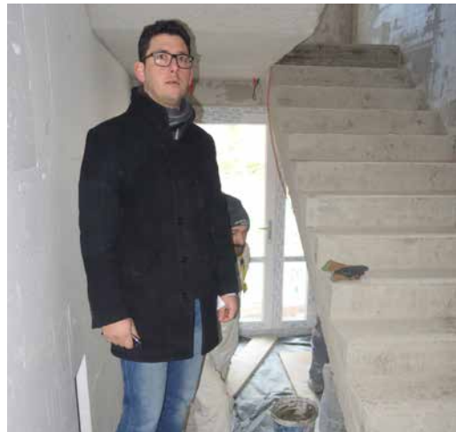
Zamjenik gradonačelnika Veselko Mutavgjić u obilasku unutarnjih radova
